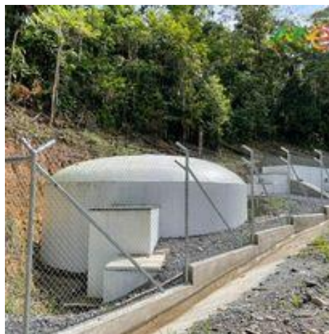
Construcción de un sistema integral de agua potable para la comunidad de Nueva Vida
